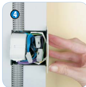
4 Plassering av aktuator i veggbox med dekklokk
