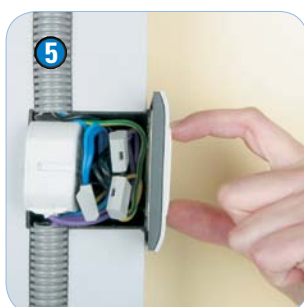
5 Plassering av aktuator i veggbox med RF-bryter i front er fullt mulig
