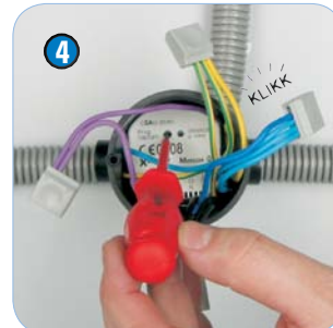
Programmeringsknappen gis et nytt kort trykk (rød LED og tilkoblet lampe slukker)
