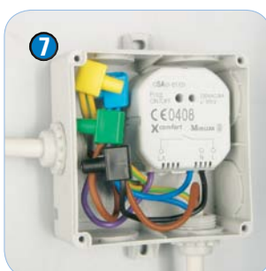
7 Montering av aktuator i tett kapsling
